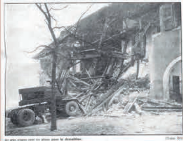
Démolition de la fonderie / maison Zurcher (1974), remplacée par les HLM « Les fougères ». Article DNA du 6 mars 1974.
